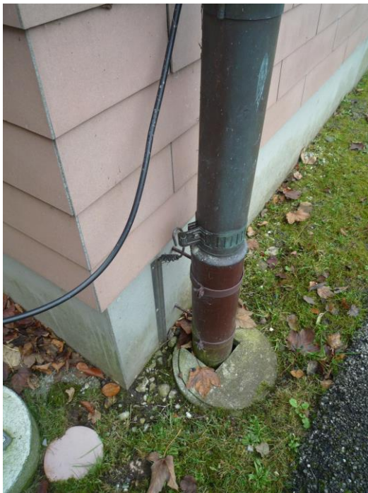
Beispiel Dachwasserfallstrang als Ableitung
